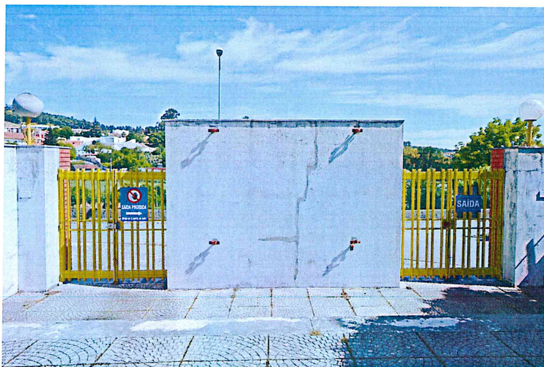
Ilustração 8 - Sinalização entrada/saída escadas
